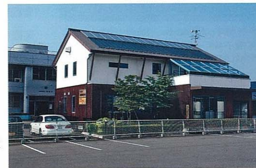
1階を事務所やデータセンター、2階を実験住宅として使用している
